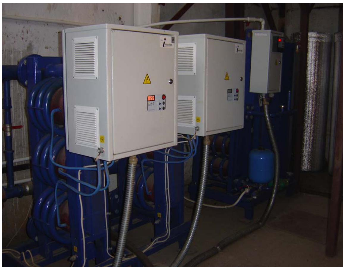
Фото 1. Узел индукционного нагрева «Титан-100(2x50)». На заднем плане установка горячего водоснабжения с баком-аккумулятором емкостью 250 л. и станция очистки воды от примесей и бактериологической очистки.
