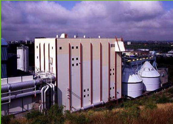
ТЭЦ на отходах Швеция, Hogdalen
