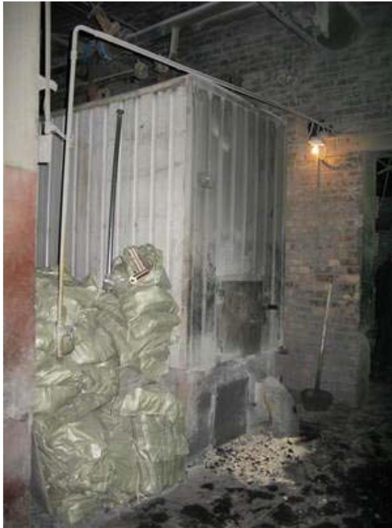
На брикеты был переведен один котель мощностью 0,8МВт, который работал на брикетах в течение суток.
